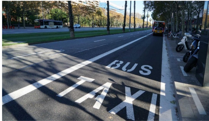
Figura 17. Tramo en la Avenida Diagonal (Barcelona) en donde se empleó una mezcla bituminosa con plástico no reciclable.
