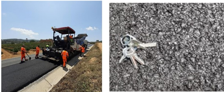
Figura 15. Mezcla BIOPHALT del proyecto BIOREPAV.
