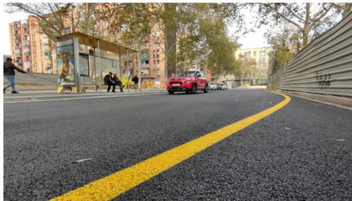
Figura 18. Tramo en calle Josep Soldevila (Sant Andreu, Barcelona) en donde se empleó una mezcla bituminosa con plástico no reciclable y residuos de tinta de tóner de impresora.
