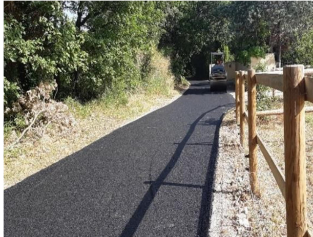
Figura 21. Vía con CarbonLight® en Ravin de Ganay, Aix-en-Provence, Francia.
