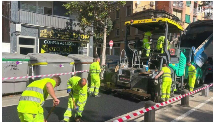
Figura 19. Rehabilitación de vía Júlia con mezcla bituminosa con árido siderúrgico, adición de polvo de NFVU, sono-reductora.
